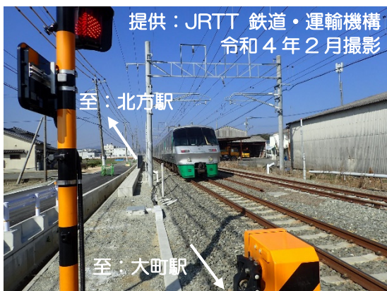
複線化された線路 (佐賀県杵島郡大町町付近)
