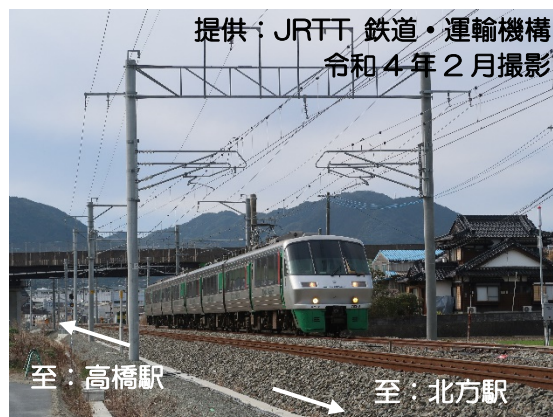
複線化された線路 (佐賀県武雄市北方町付近)
