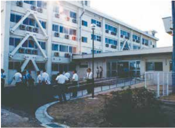
学生寮「偲聖寮」の耐震・機能改修 2000 改修を終えた「偲聖寮」
