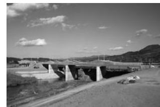
東北線平泉～前沢間衣川橋りょう
