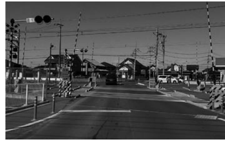
拡幅やカラー舗装を実施した踏切
