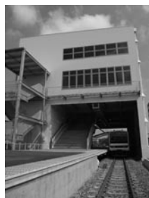
Smart Station 実験棟
