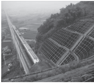
北陸新幹線 高崎・安中榛名間
