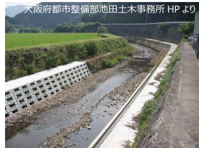
護岸ブロック
