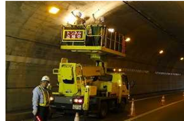
写真一近接目視によるトンネル点検状況
