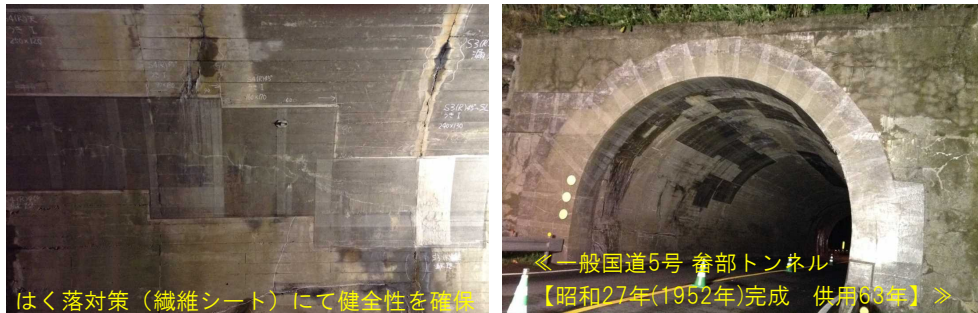
写真一 適切に管理されているトンネル例
