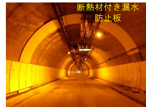
写真一漏水・氷柱対策工（補修対策） ※断熱材付き面型パネルによる漏水対策
