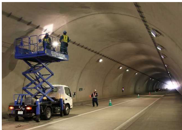
一般国道278号 豊崎ひろめトンネル（函館市）
