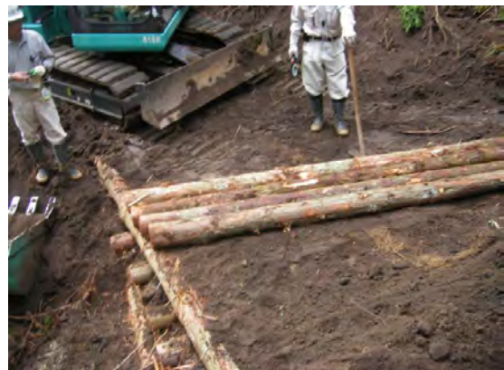
⑧流水を誘導するため、細い丸太と太い丸太を利用しU字状に横木を組む。さらに路盤を安定させるために、横木を適時敷設する。
