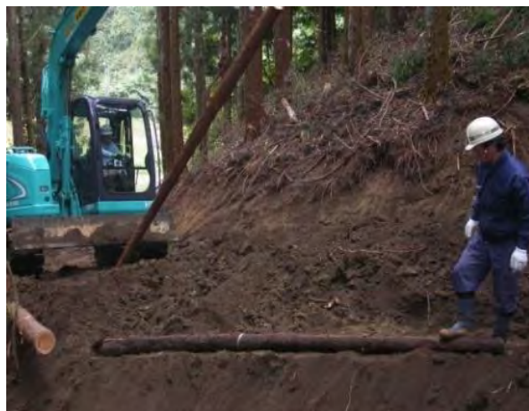
②路肩部分に桁丸太を敷く。施工後、土砂が抜け底が抜ける恐れがあるため、桁をバックホウで押し込み深く入れる。
