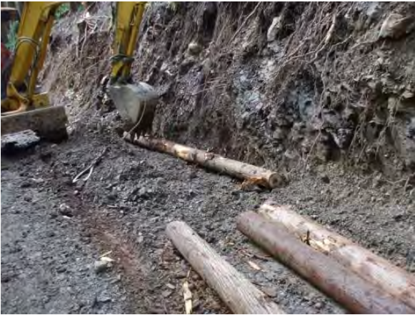
①法面の下部を掘削し、桁(基礎丸太)を法面に並行して敷設する。
