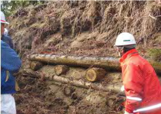
法面（切法）補強
