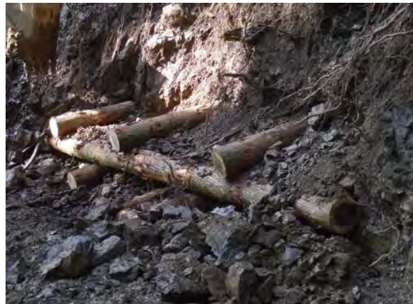
④2段目の横木を②と同様に施工する。
