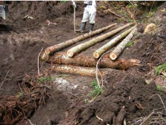
⑤横木を沢方向に向けて敷設し、桁に釘(10寸)で止める。
