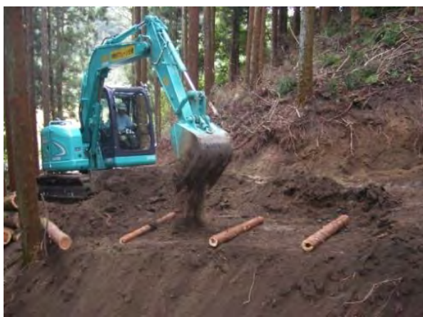
④横木を置き、桁と釘(10寸)で固定した後、空隙は埋め戻す。
