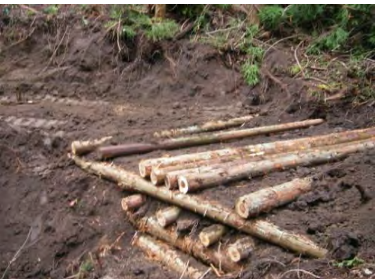
⑨路盤を安定させるために、横木を適時敷設
