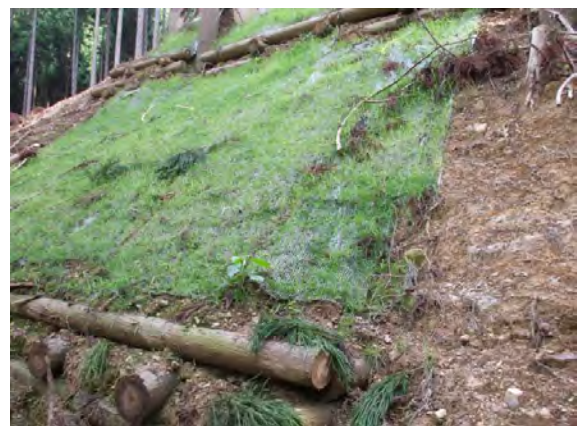
※崩れやすい土質の場合は、植生マットを敷設し法面の保護を図る。
