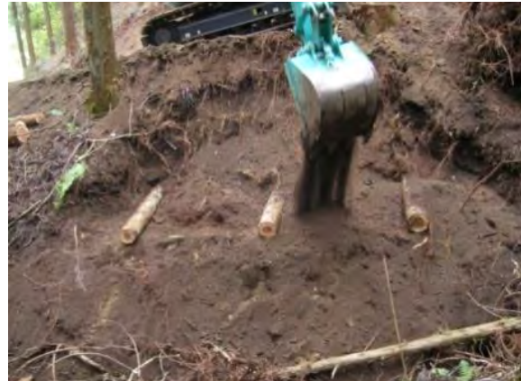
⑥桁と横木の空隙は埋め戻し、しっかりと転圧する。
