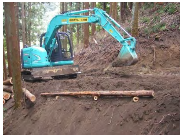
⑥基礎の桁との勾配を4分になるように横木に桁を釘で止めたら、埋め戻し・転圧をしっかり行い路盤を仕上げる。
