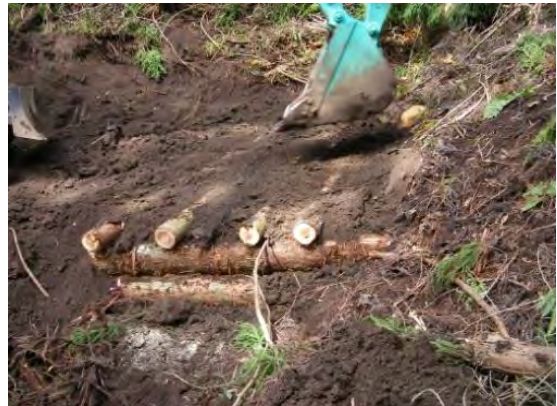
⑥横木の空隙は埋め戻し、しっかりと転圧する。
