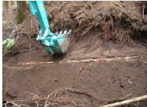
④桁(基礎丸太)背面の空間をしっかりと埋め戻し、転圧する。なお基礎丸太は完全に地中に埋まるように埋め戻す。
