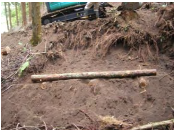
⑦2段目の桁を置き、下の横木と釘で止める。以後は④以降の作業を繰り返す。
