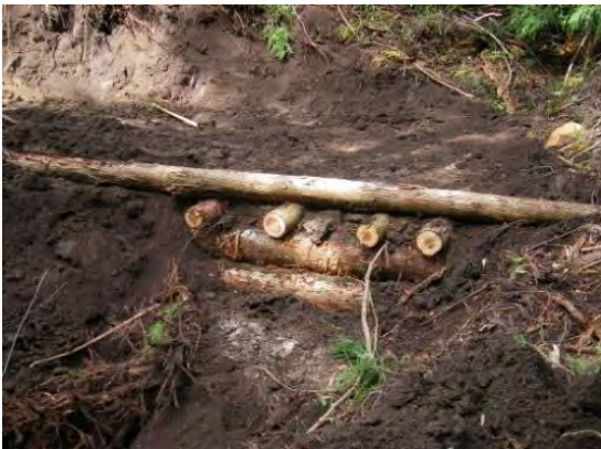
⑦桁を置き、下の横木と釘で止める。上流部を埋め戻し、水平に転圧する。
