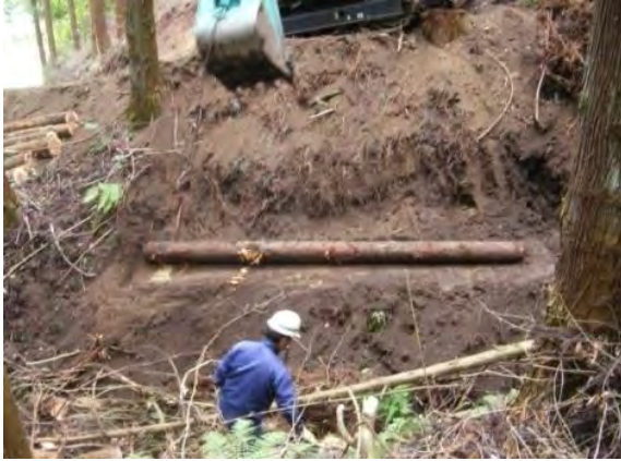
③桁(基礎丸太)を路面肩と平行に置く
