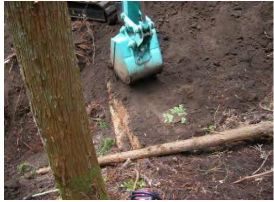
④桁(基礎丸太)の上流の空間をしっかりと埋め戻し、水平になるよう転圧する。
