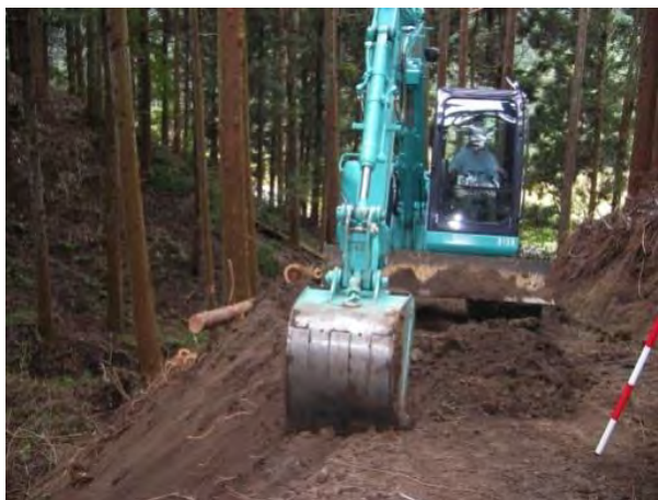
①路盤を約50cmほど掘削し、丸太の敷設面を転圧する。
