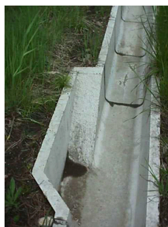
写真－事例 18－7 スロープ付きU字溝
