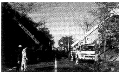
写真一事例 19-1 設置作業風景
