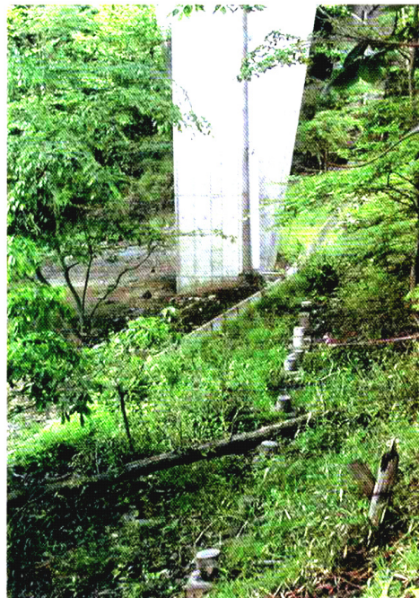
写真－事例 22－2 橋梁下の状況
