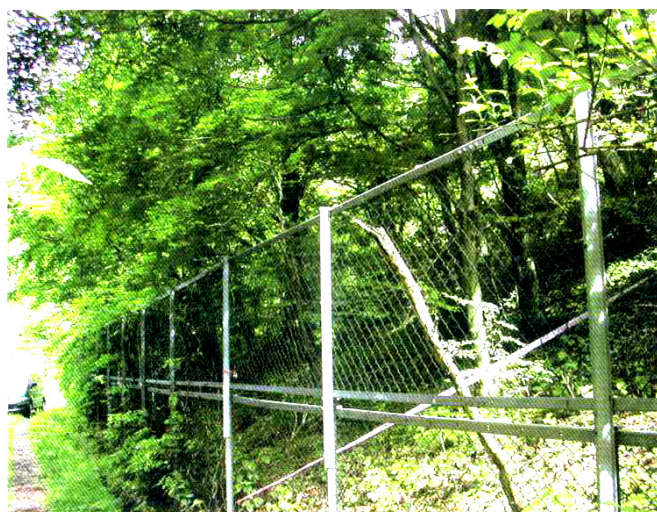
写真－事例 22－3 侵入防止柵（上部が嵩上げ分）
