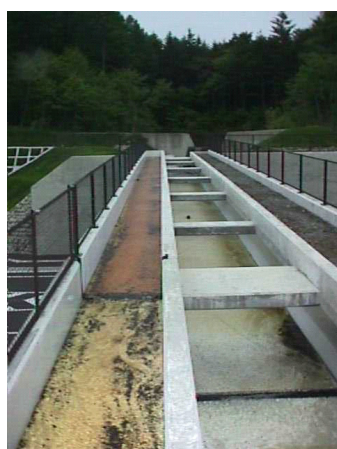
写真－事例 18－6 動物の通路（両端）を確保した水路橋
