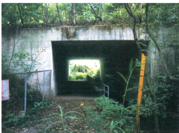
写真－事例 22－1 ボックスカルバートの状況
