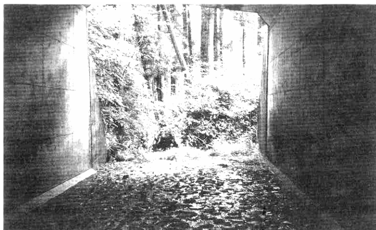
写真一事例 25-3 ボックスカルバートの内部の状況
