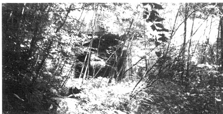
写真一事例 25-2 ボックスカルバートの入口の状況
