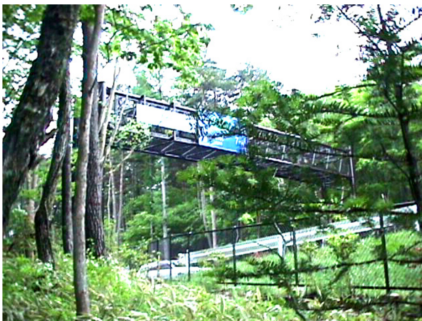
写真－事例 18－1 ヤマネブリッジ
