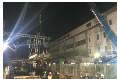
東門前駅付近の仮橋の撤去
