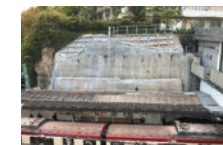
追浜駅構内法面防護工事
