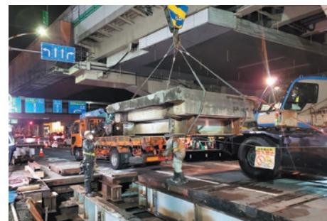
産業道路部分の踏切版の撤去
