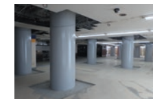
平和島駅構内高架橋
