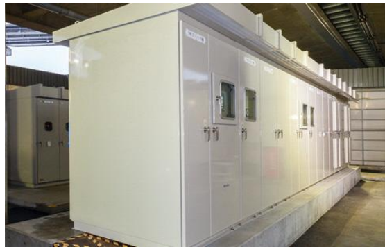
図 4-7 回生電力貯蔵装置設置イメージ
