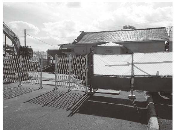
比布駅旧駅舎解体の様子
