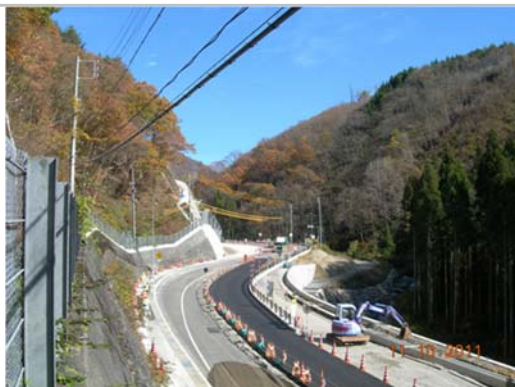
【車線拡幅状況】
