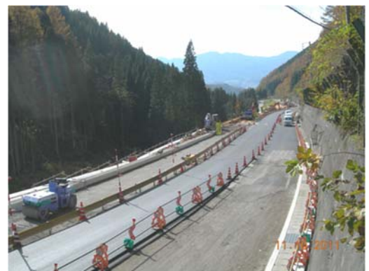
【舗装工事状況】
