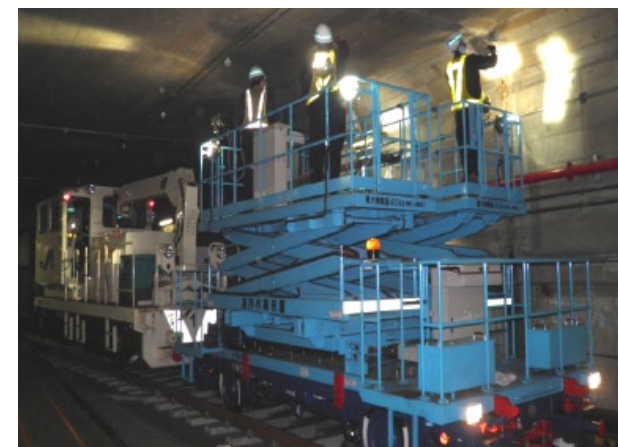
高所作業車による特別全般検査
