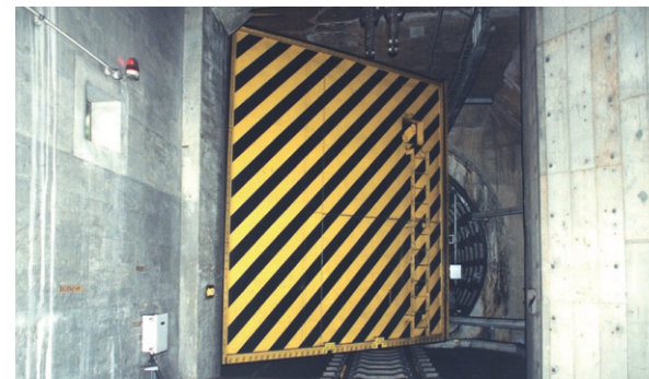
トンネルの断面を閉鎖することができる
