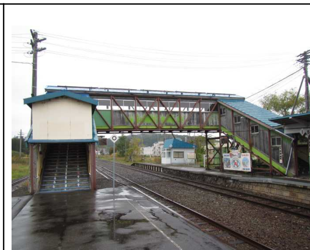
軟弱地盤上の乗換跨線橋
