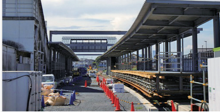
軌道工事、電気工事等を進めていきます(愛宕駅)
