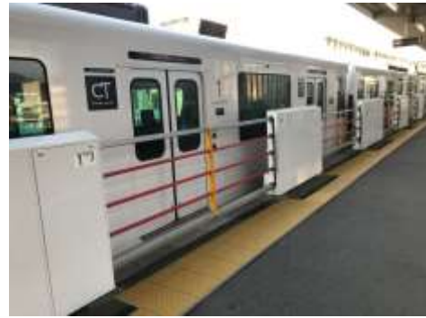
＜九大学研都市駅で稼働中の軽量型ホームドア＞
