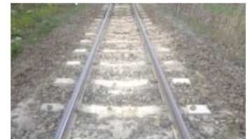
渡島砂原駅～掛澗駅間の線路状態
