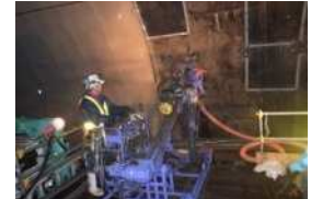
トンネル変状対策
