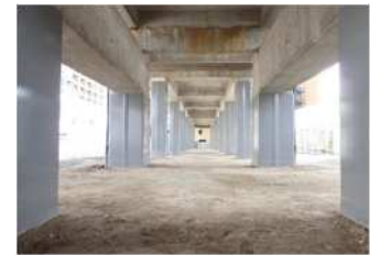
耐震補強後の新札幌高架橋
