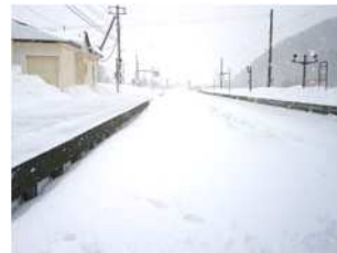
例② 除雪前の駅構内の線路上の降積雪状況
