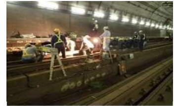
在来線(貨物列車用)レールの交換
