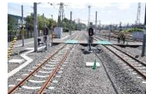
異常時運転取扱いや設備メンテナンスの実習、車両の分割・併結訓練などに使用する実習線
