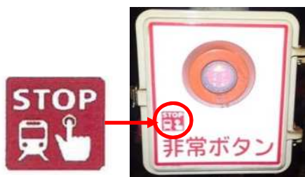
ピクトグラムを表記した踏切支障報知装置非常ボタン
