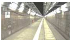
吉岡定点下り線誘導路のトンネル床誘導線
