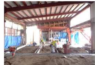
大森駅耐震補強（基礎工事状況）
