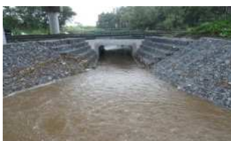
非常導水路の新設
