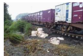
函館線山越駅～八雲駅間 熱田川氾濫・路盤流出状況
