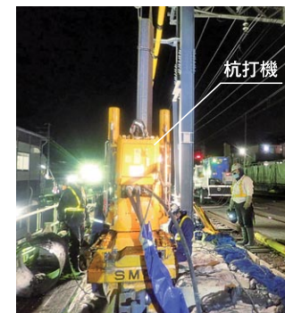
千歳烏山駅～仙川駅間 (第8工区)
