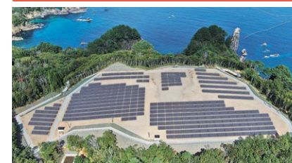
宮古市の発電設備
