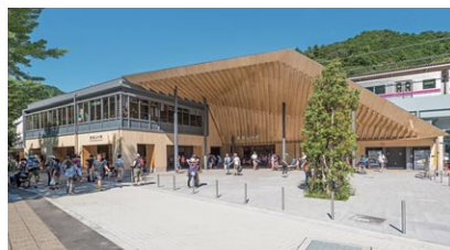
施工した高尾山の玄関「高尾山口駅舎」
