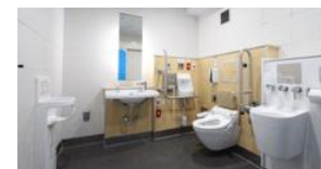
▲トイレ洋式化・多機能トイレ整備（外苑前駅）
