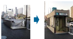
▲完全防水型出入口
