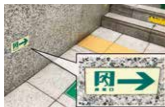
▲蓄光式避難誘導明示物
