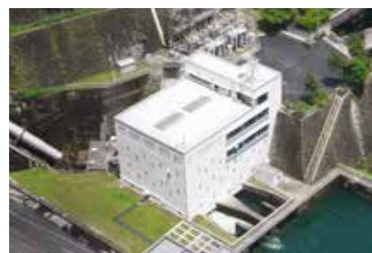
▲多摩川第一発電所
