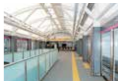
▲ホームドアと視覚障害者誘導用ブロック
