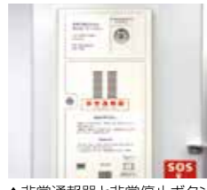
▲非常通報器と非常停止ボタン
