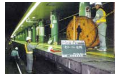
▲光ファイバー工事
