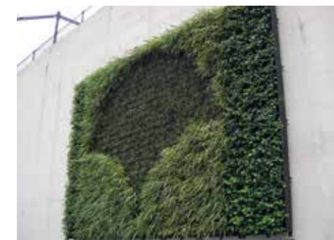
▲壁面緑化(大島車両検修場)
