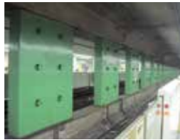
▲耐震補強工事をした駅の中柱
