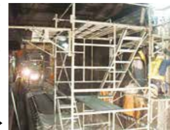
長寿命化工事▶
