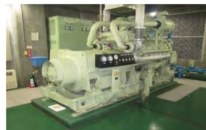
固定式自家発電機の整備
