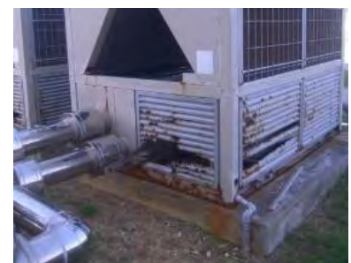
空調設備の更新
