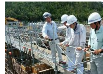
防衛施設の建設工事（監督業務）を行う事務官等（イメージ）
