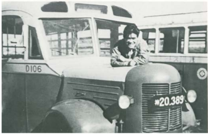
船舶用のディーゼルエンジンを搭載した交通局技術陣の傑作、通称「ポンポン」（昭和 23 年頃）
