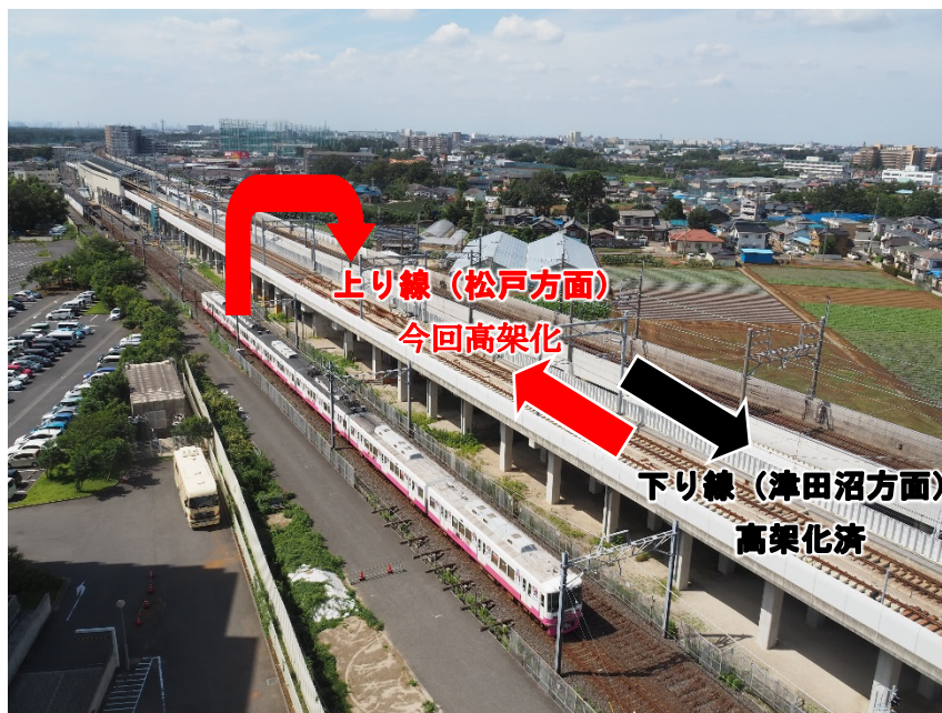
写真：新鎌ヶ谷駅付近工事状況
