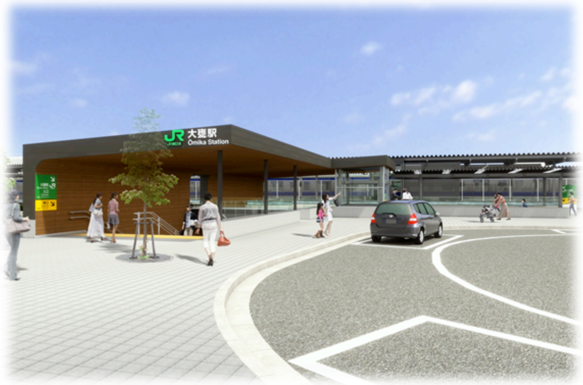
大甕駅西口広場 外観
