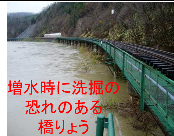
(例: 宗谷線 糠南・雄信内間 問平陸橋)
