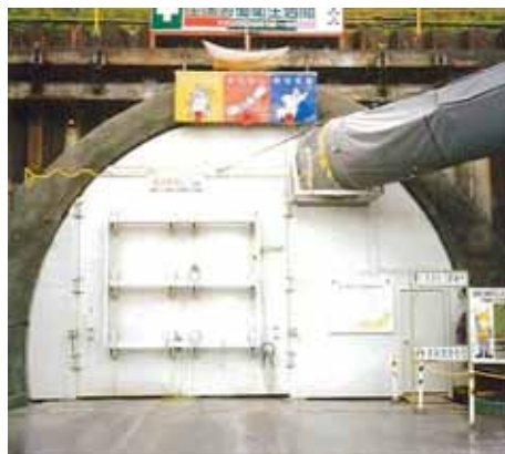
工事騒音・振動 軽減対策(例)
