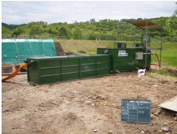
H18 常呂川橋A 1 橋台外工事
