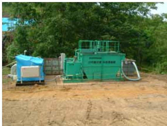
H17 川東改良工事（アーチカルバート）
