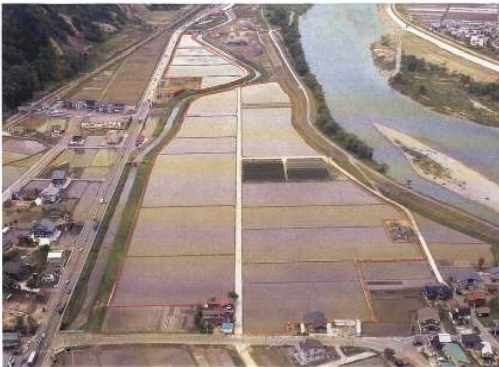
写真-2 経営体育成基盤整備事業 宇賀地地区
