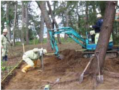
腐植土除去の試験実施状況
