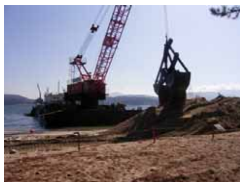
サンドバイパス施工中の写真
