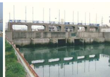
新川樋門(碧南市)
