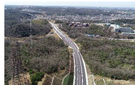
国道248号瀬戸東バイパス
