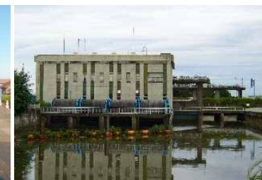
水場川排水機場 (清須市)
