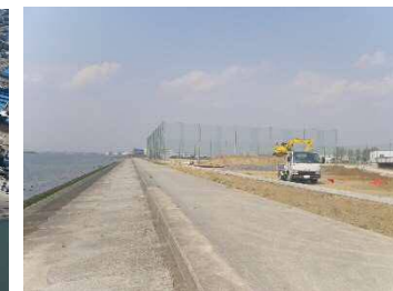
多目的広場造成工 65
