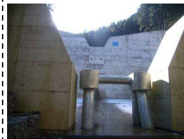
大千瀬川第10支川(東栄町)
