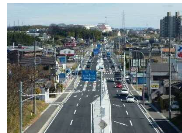
国道155号東海拡幅
