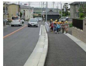
(一)和合豊田線(東郷町) 対策内容:歩道設置
