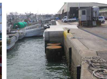
大浜漁港陸揚岸壁 (碧南市)
