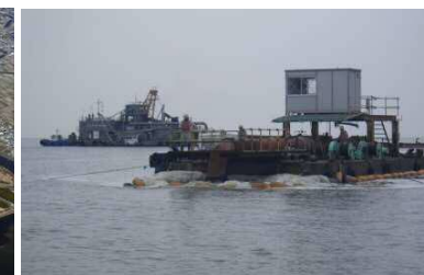
覆砂の作業状況
