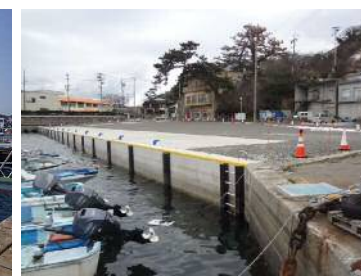
篠島漁港物揚場 (南知多町)
