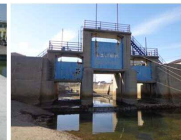
布土川樋門(美浜町)
