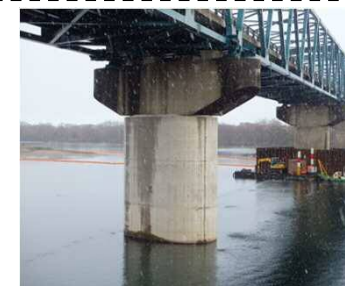
橋脚補強 (一)大垣江南線(尾濃大橋)
