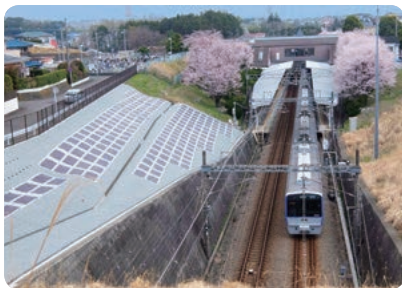
弥生台駅の薄膜型太陽光発電設備
