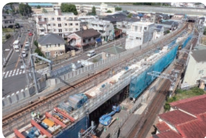
上り線の高架化に向け工事が進む（星川4号踏切付近）
