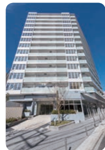
建替事業により誕生した「グレースシア茅ヶ崎」
