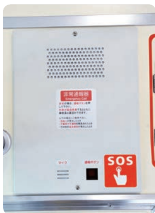
電車内に設置した非常通報器
