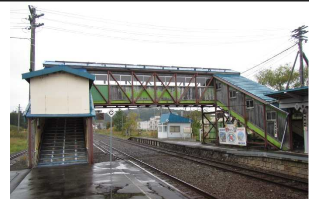
軟弱地盤上の乗換跨線橋
