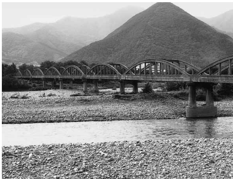
補修が予定されている昭和橋
