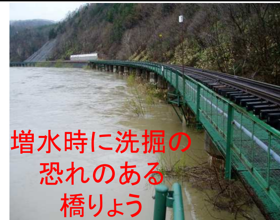
(例: 宗谷線 糠南・雄信内間 問平陸橋)
