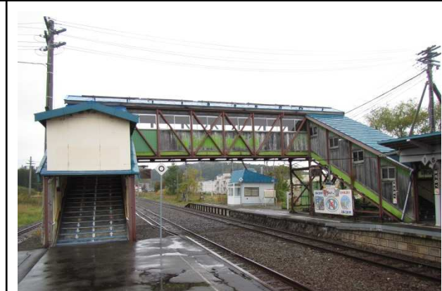
軟弱地盤上の乗換跨線橋
