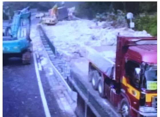
<復旧作業写真>
