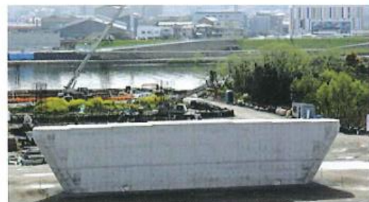
平成26年3月 大分川左岸側より
