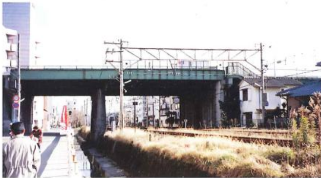
撤去前の大道陸橋
