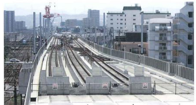
平成 23 年 日豊本線 (田室町)
