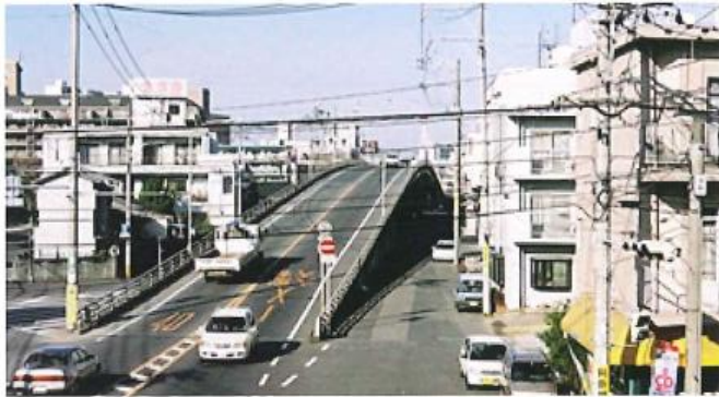
撤去前の春日陸橋
