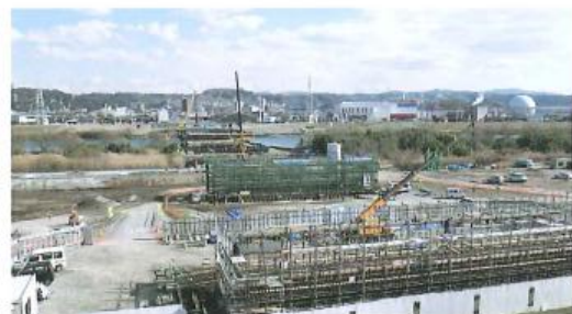
平成26年1月 大分川左岸側より
