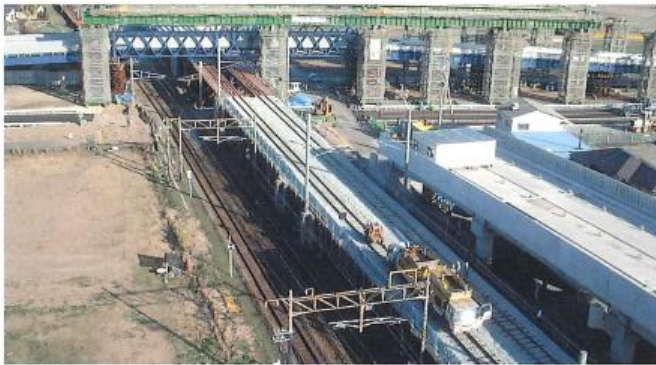
撤去前の万寿陸橋
