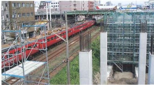
平成 17 年 日豊本線 (田室町)
