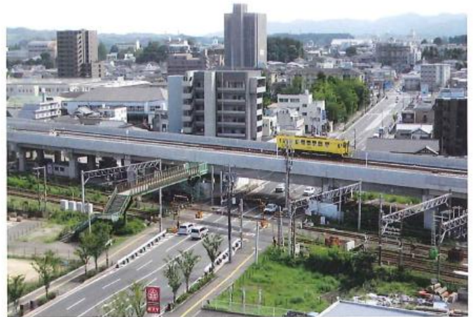
〈部分開業〉 豊肥・久大本線高架開業後 日豊本線踏切が残っている
