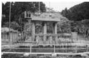
新深良水門 東海地震に備えた鉄骨の近代的水門
