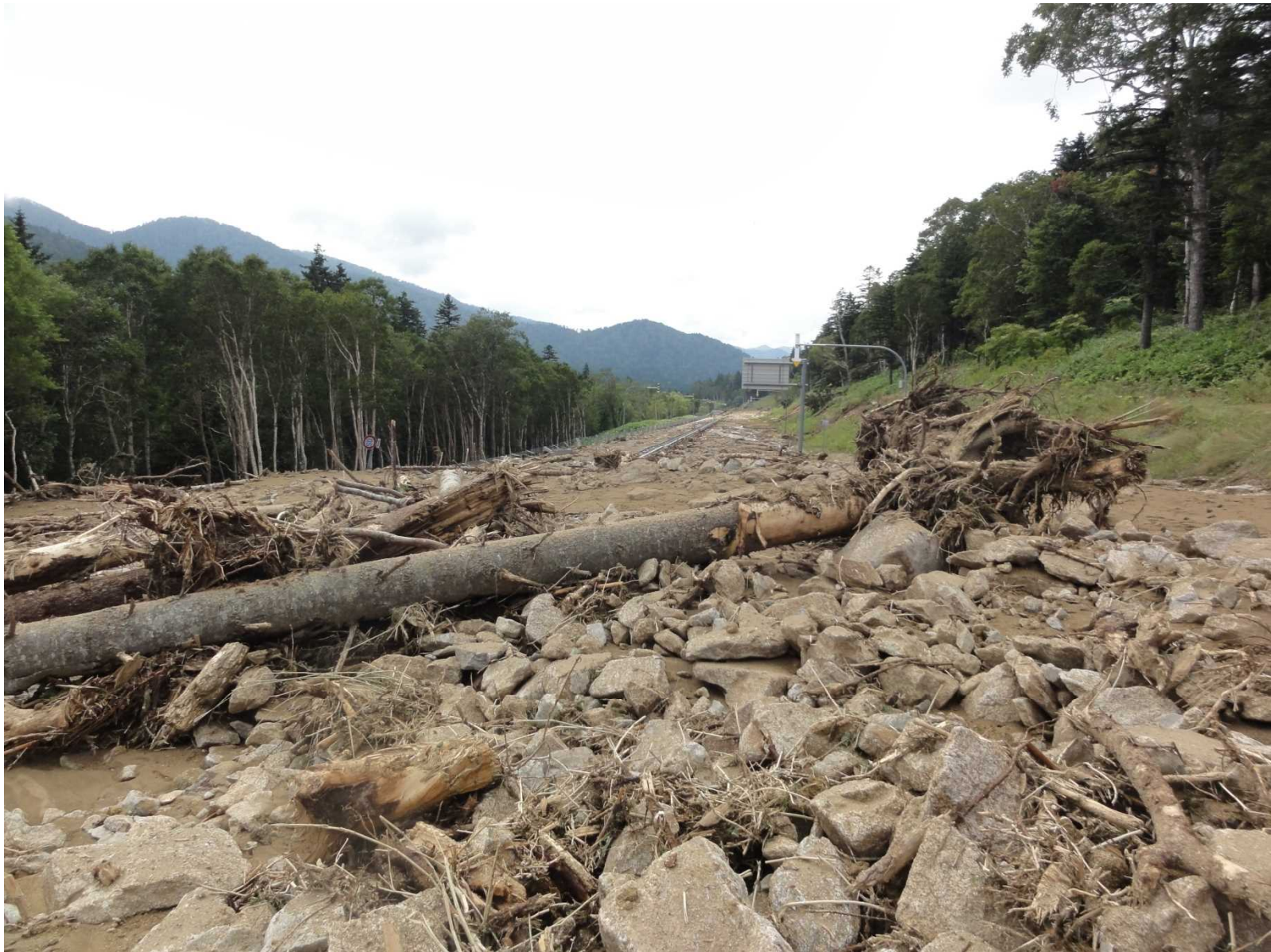
国道274号 日高町 日勝峠8合目付近 (H28.9.3の状況)
