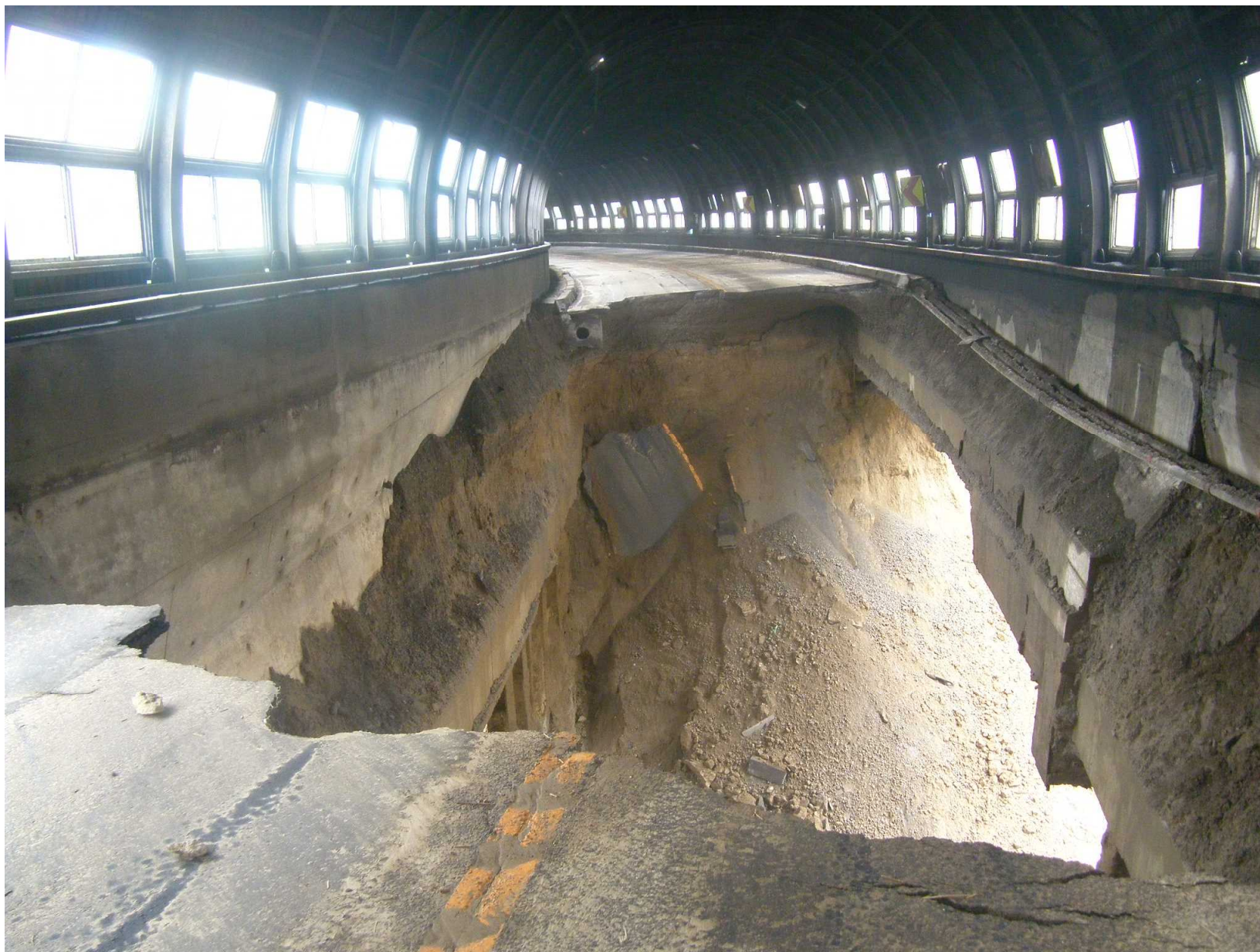
国道274号 日高町 三国の沢覆道 (H28.9.3の状況)
