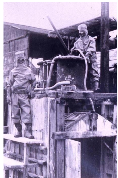
当時の作業風景
