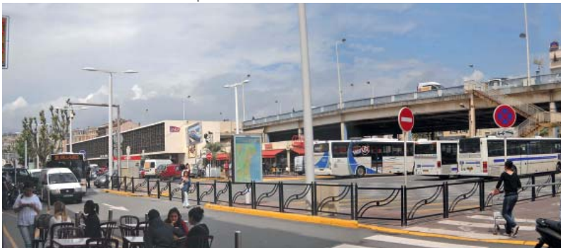
L'ancienne gare, avant les travaux de rénovation
