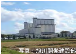
写真：旭川開発建設部
