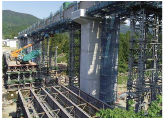
▲建設中の横川高架橋
