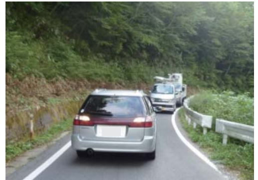
▲すれ違い困難状況
