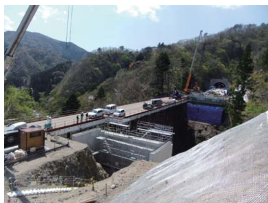
▲建設中の櫓這橋
