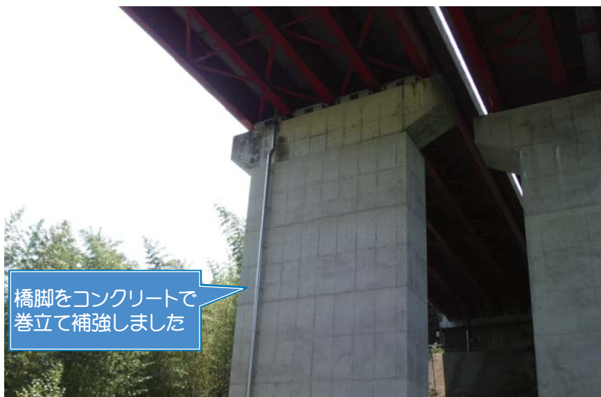
▲一般国道6号 松久須根大橋 (いわき市) の耐震補強後の状況
