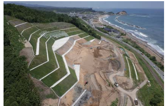
▲建設中の久之浜バイパス
