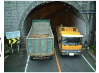
▲波立トンネルの状況
