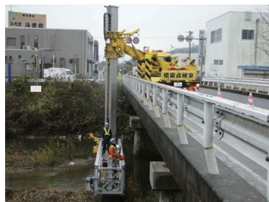
▲一般国道6号 大久川橋 (いわき市) の点検状況
