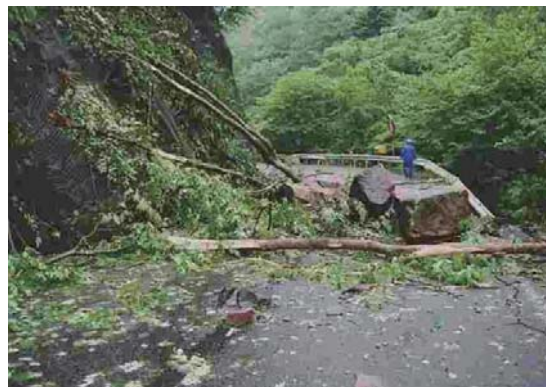
▲特殊通行規制区間での災害状況
