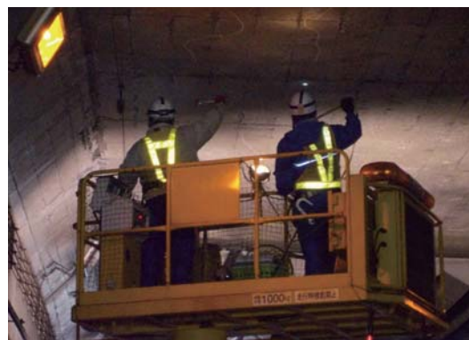
▲一般国道6号 久世原トンネル (いわき市) の点検状況
