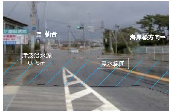
▲津波浸水状況
