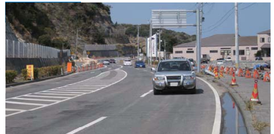
▲船舶や堆積物を取り除くとともに、法面の応急対策を行い、被災から約1箇月後の4月10日に全面開放しました。
