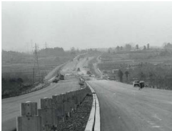
*3 [九州自動車道]
