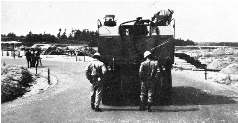
*23 [ブルーフローリングによる締め固め不良個所の確認状況] (『東名高速道路建設誌』・日本道路公団・昭和45年3月25日)
