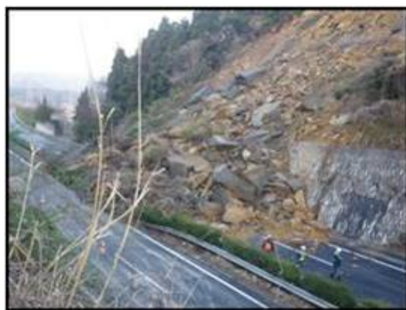
*5 【常磐道 いわき勿来—湯本間の切土部の崩落】
