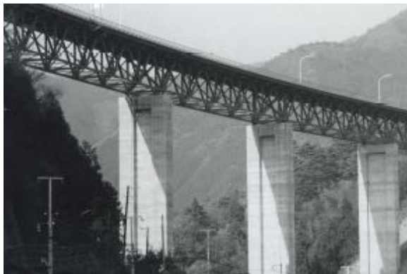
*42 [中央自動車道 底沢橋]
