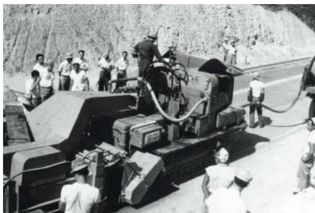
*16 [阪奈道路での大型スタビライザーを使ったセメント安定処理試験施工]
