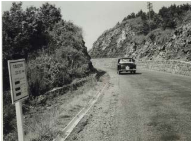
*15 [クロソイド曲線を採用した遠笠山道路]
