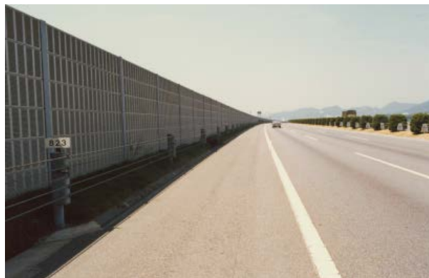
*22 [遮音壁による高速道路の騒音対策]
