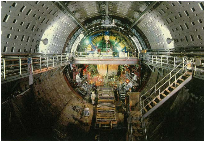
*2 [東京湾アクアラインの地中でのシールドトンネルの閉合]
