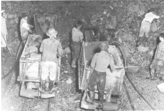
*12 [関門トンネル掘削工事]
