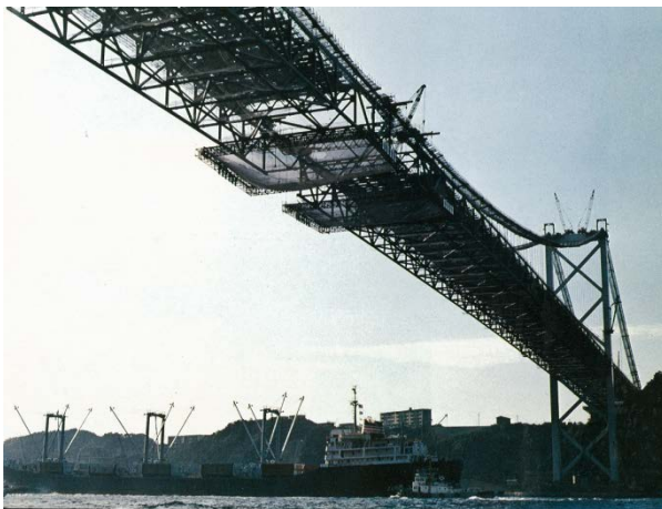
*8 [閉合目前の関門橋補剛桁]
