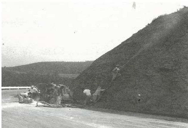
*47 [名神高速道路でのコンクリート吹付工] (『過去に学ぶ』・(財) 高速道路技術センター・平成2年11月)
