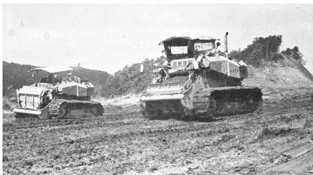
*45 [ローム層での盛土施工に使用されたスクレープドーザー] (『東名高速道路建設誌』・日本道路公団・昭和45年3月25日)
