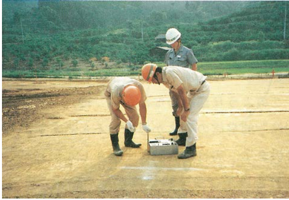
*6 [ラジオアイソトープ(RI)計器を使った密度管理] (『過去に学ぶ』・(財) 高速道路技術センター・平成2年11月)
