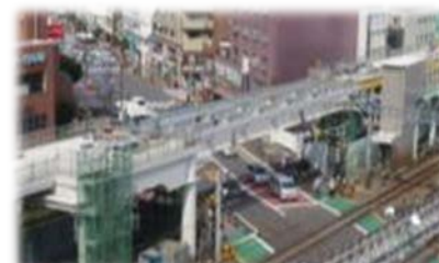
竹ノ塚駅付近 連続立体交差化事業
