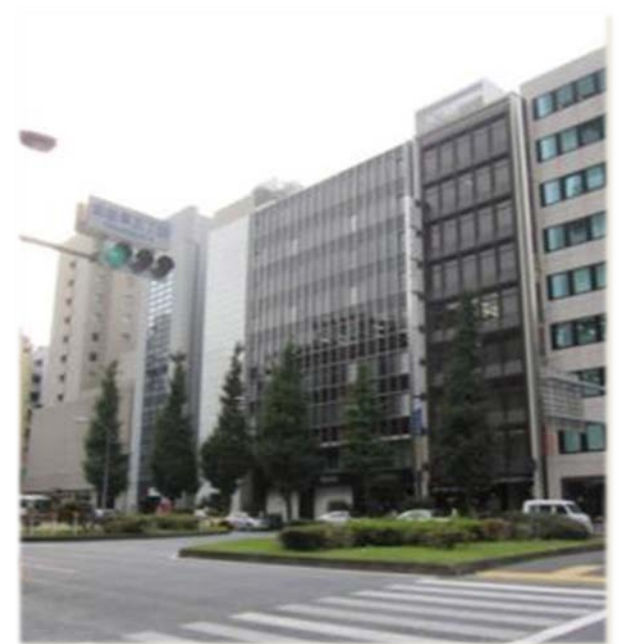
現況建物写真
