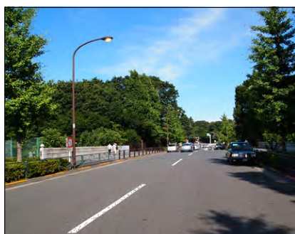
④外苑橋 ・都道414号より東側に外苑橋を見る
