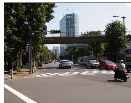
⑪都道418号 ・都道418号より国立競技場と東京体育館を結ぶ横断橋を見る ・車両のメインアクセスとすることを想定
