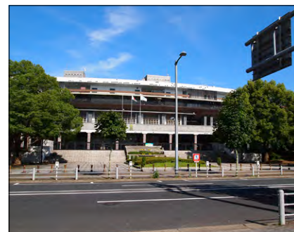
⑩国立競技場正門 ・都道418号より国立競技場正門を見る
