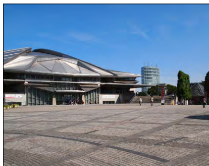
②東京体育館メインアリーナ ・東京体育館メインアリーナを北西側広場より見る
