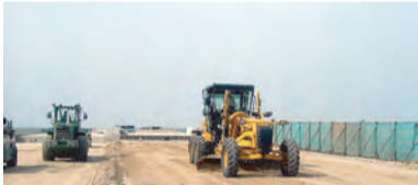
▼砕石路盤の作業状況
