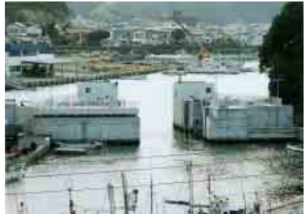
図 1-1-12 船溜前面に設置した水門 (仁科漁港海岸：西伊豆町)
