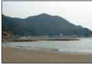
自然素材を用いた突堤整備 (宇久須港海岸深田地区：賀茂村)
