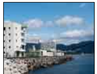
伊東市下水処理場 護岸(伊東市)
