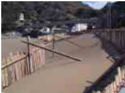
図 1-1-20 雲見漁港海岸の飛砂対策
