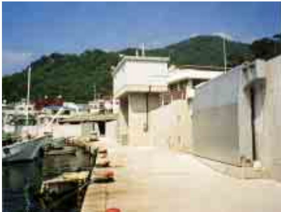
図 1-1-11 胸壁・陸間の整備 (田子漁港海岸：西伊豆町)
