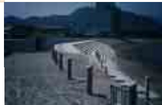
図 1-1-13 堤防の嵩上げとともに傾斜堤に改良 (松崎港海岸：松崎町)
