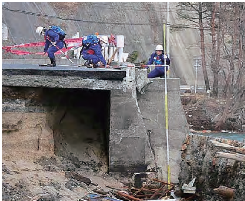
道路復旧のため調査を行う隊員
