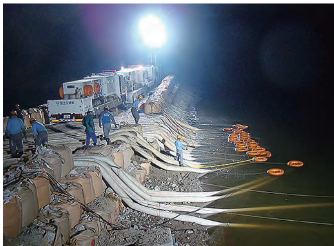
昼夜を問わず続けられた排水作業
