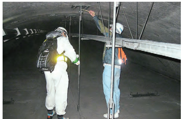
天井板緊急点検の状況（昨年12月実施、月山第一・第二トンネルとも異常無し）
