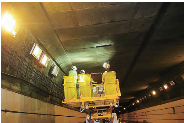
天井板緊急点検の状況（昨年12月実施、月山第一・第二トンネルとも異常無し）
