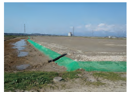
サンドマット施工状況
