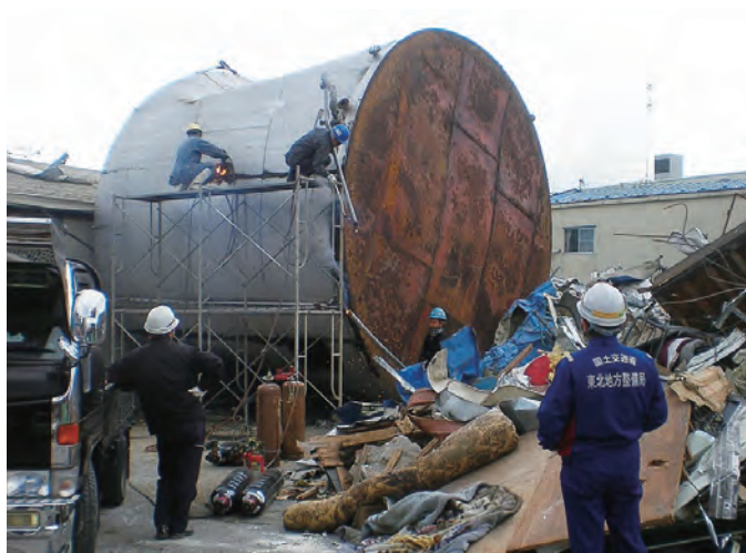
タンク撤去のための現地調査状況
