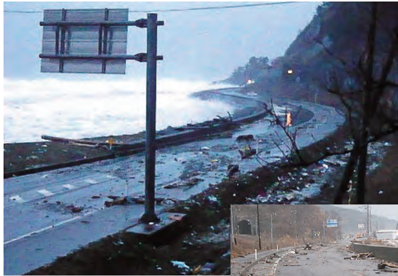
平成24年4月4日 越波による被害状況 (10時間35分通行止)
