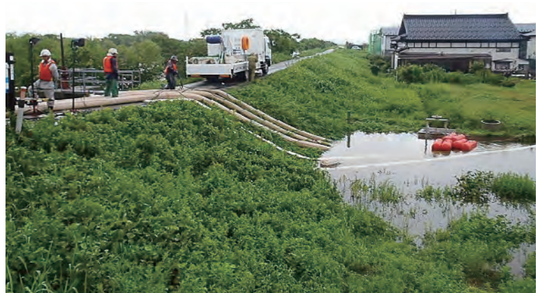
三川町藤島川 稼働状況(排水ポンプ車)
