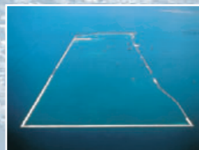
空港島護岸完成
