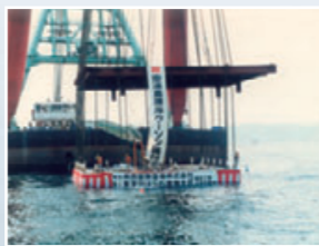
空港島護岸築造工事着工
