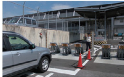
車両侵入防止装置で不法侵入対策を強化
