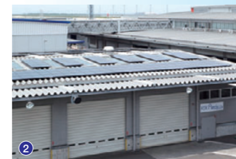
② 医薬品専用共同定温庫に「太陽光発電」システムを導入
