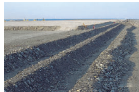
空港島は砂ではなく、岩を砕いたような材料で埋め立てしているため、液状化しにくい地盤となっています。
