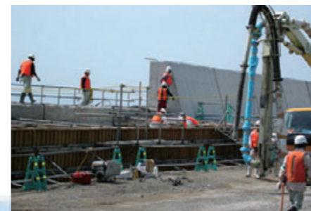
護岸のかさ上げ工事(2005年)
