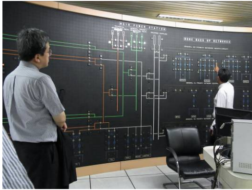
写真 1-33：特高変電所内部
