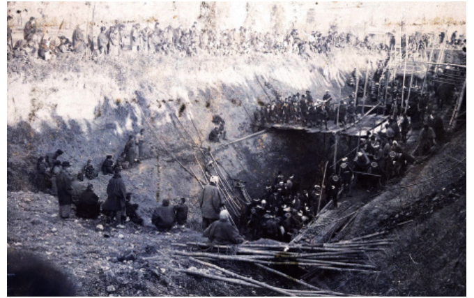
砂山池工事風景(写真提供:豊郷町四十九院水利組合)
