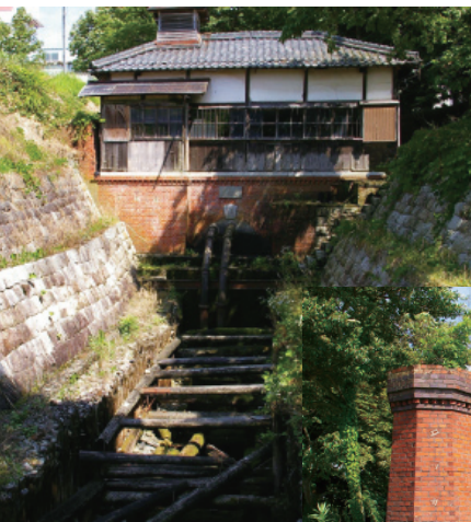
砂山池揚水機場。正面建物内には揚水ポンプが設置され、屋根の小窓からは水の放流を知らせるサイレンが鳴る。
