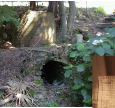
ボイラー室と煙突があった所 (砂山池揚水機場)
