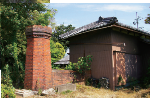
龍ヶ池揚水機場。裏に池がある。
