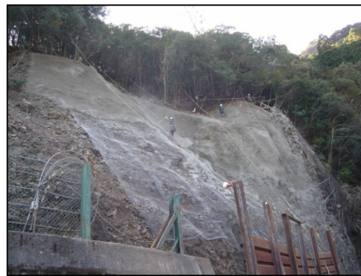
▲法面復旧の状況
