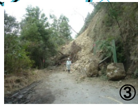
とつかわむら たけとう 十津川村竹筒地区で発生した土砂崩落 (平成21年3月)
