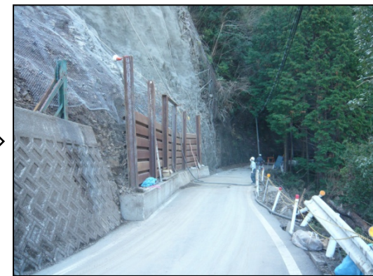
▲仮復旧の状況
